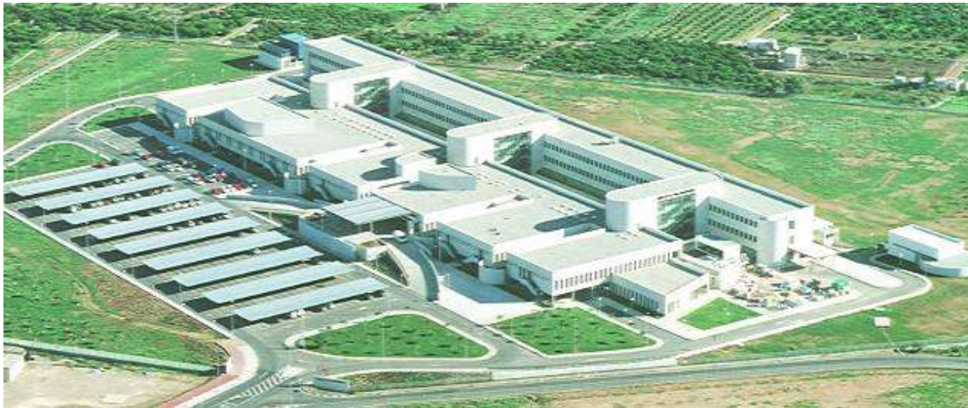
Hospital La Plana. Vila-real (Castelló)
