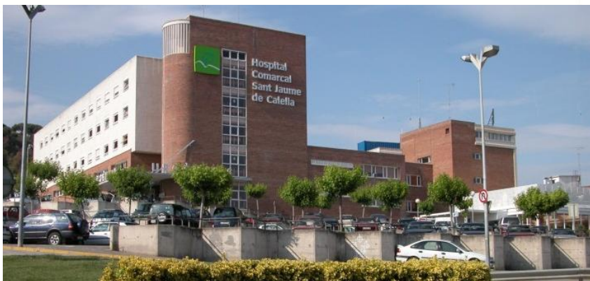
Lloc: Sala d'actes de l'Hospital Comarcal Sant Jaume de Calella Carrer de Sant Jaume, nº 209 - 217. 08370 – Calella. Barcelona
